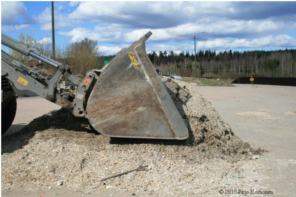
Kuva 6. Poistetaan kasan yläosa kaivinkuormaajalla.
